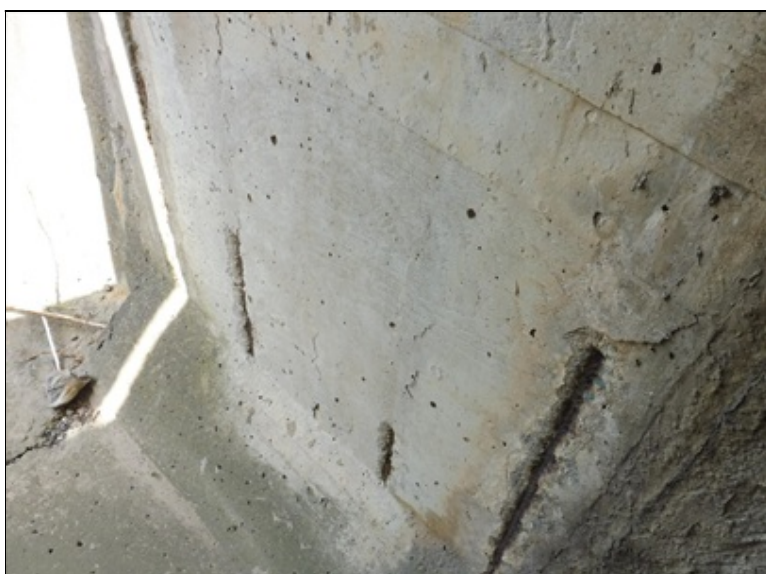
Odpadlá krycí vrstva + odhalená korodující výztuž ve stěně prefa.
