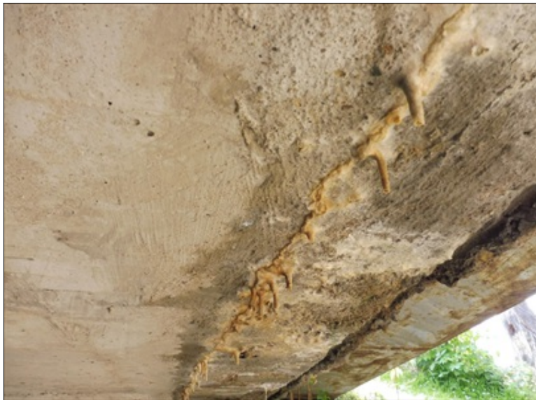
Zatékání na okraji NK.
